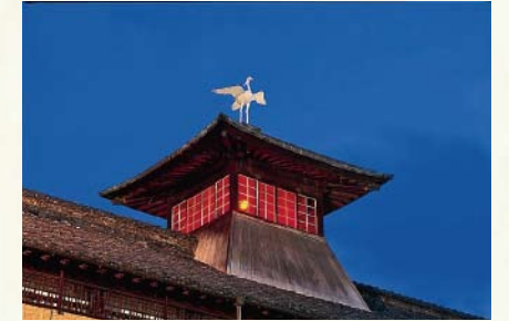
道後温泉本館三層楼の屋上にある振鷺閣。閣内の広さは約1坪、周囲の窓にはめた赤いギヤマンは、夜になると中央天井の吊ランプが灯り、夜空を彩る。
